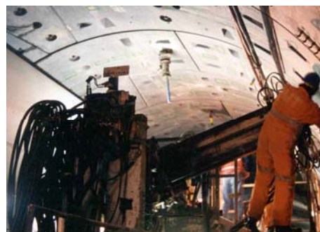
Túnel de Storebaelt (Dinamarca)
