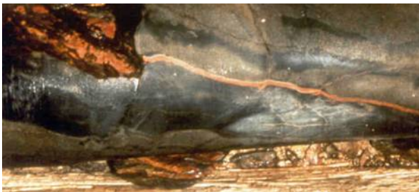
Esquistos inyectados – Presa de Esch-sur-Sure (Luxemburgo)
