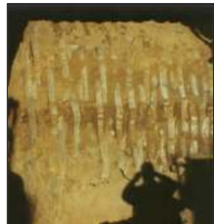
Foto 2.- Dientes marcados en frente de excavación tras inyección.
