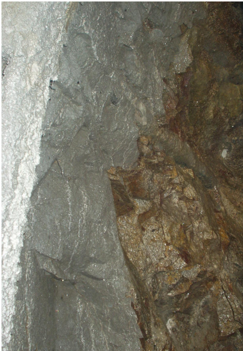
Detalle de excavación con las discontinuidades colmatadas tras el tratamiento.
