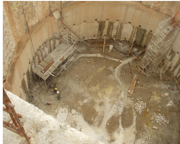
Vista general del pozo y paraguas del túnel.
