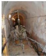
Vista del acceso a la galería perimetral y de las instalaciones de inyección. Detalle de la máquina de perforación en la galería perimetral.
