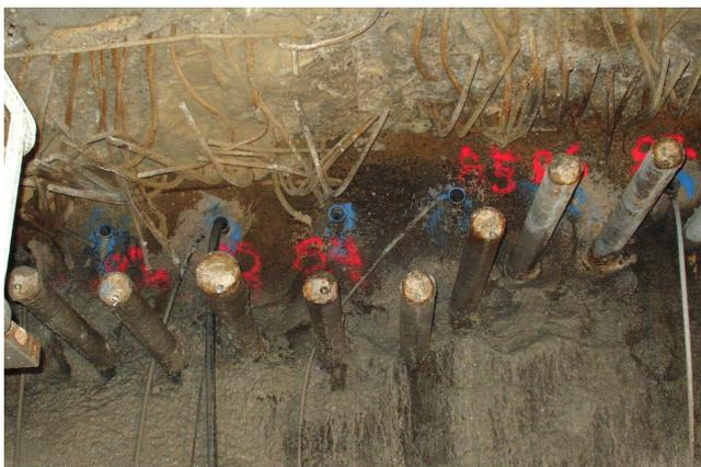
Vista de los tubos para inyección (en azul) por encima del paraguas de micropilotes.
