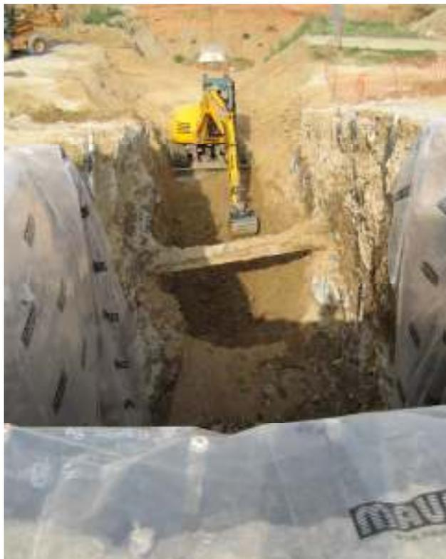
*Excavación de la trinchera al pie de la carretera y en dirección perpendicular a ésta, para colocación de la tubería de gran diámetro.*
