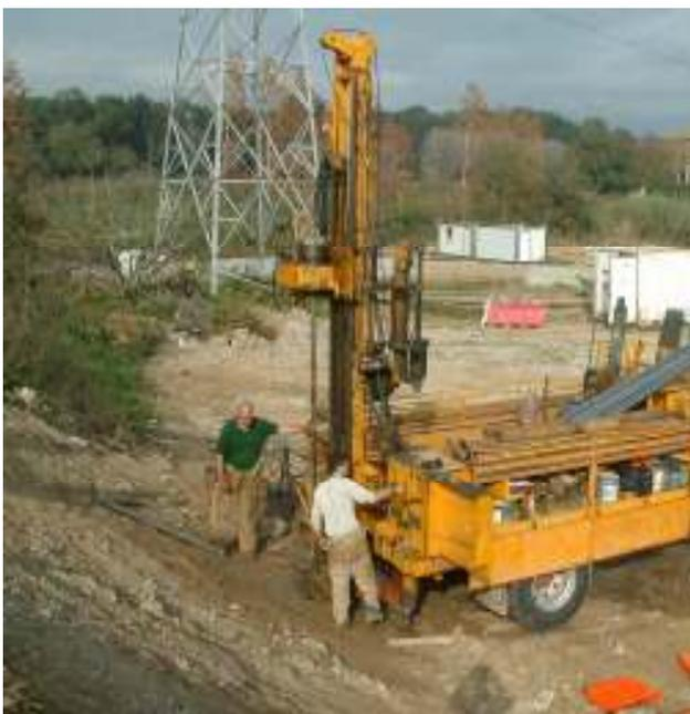
*Ejecución de sondeo por encargo de SUMSERT para caracterización de la zona inyectada.*
