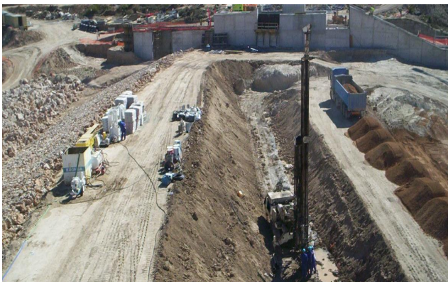
Vista general de la zona objeto del tratamiento.
