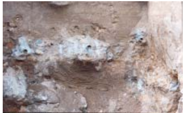
Detalle de la elevada consolidación del terreno arenoso, al quedar marcadas las uñas de la pala excavadora.
