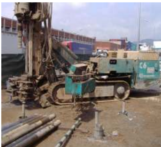
Perforadora Casagrande C6 de TECSOL Fonaments Especials durante la ejecución de los taladros para la colocación de los tubos manguitos.
