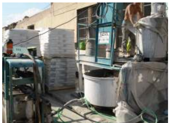
Bomba de inyección a la izquierda de la imagen. Conjunto de tanque de homogenización y mezcladora de alta revolución (derecha inferior y superior, respectivamente). Al fondo palets de microcemento A12 y A32 en sacos.
