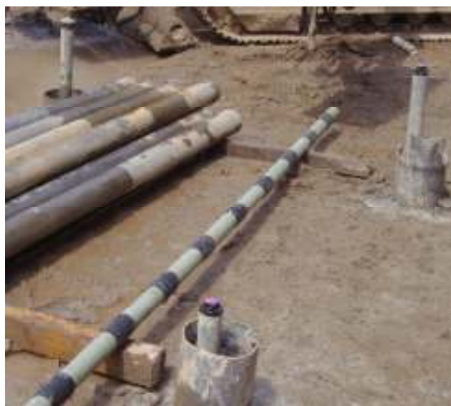
Tubo manguito de PVC con 3 válvulas antirretorno cada m.l. de tubo. Tubos manguito ya instalados en el interior de los pasantes colocados para evitar los servicios existentes.
