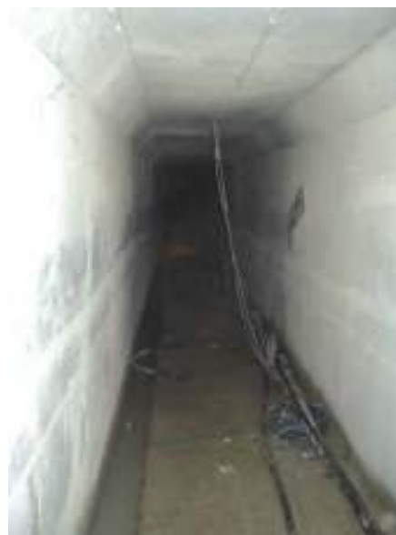
Vista de la galería desde la que se realizó la inyección.
