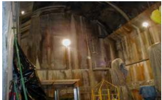
Aspecto de la cámara de válvulas antes de los trabajos de inyección de microcemento.
