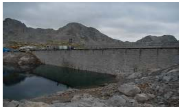
Vista del trasdós de la presa durante los trabajos de inyección.
