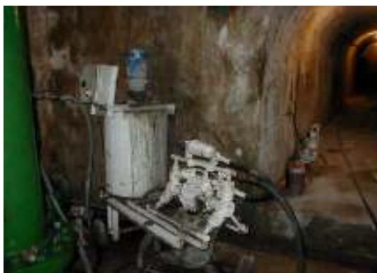
Vista de los dos equipos de inyección empleados en los trabajos. Equipo dosificador y agitador en superficie y tanque de homogeneización y bomba de inyección en la galería perimetral.
