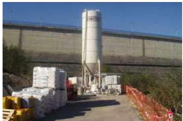
Vista general de las instalaciones exteriores y acopio de microcemento.
