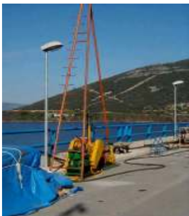
Vista de uno de los dos equipos de inyección y perforación empleados en los trabajos.
