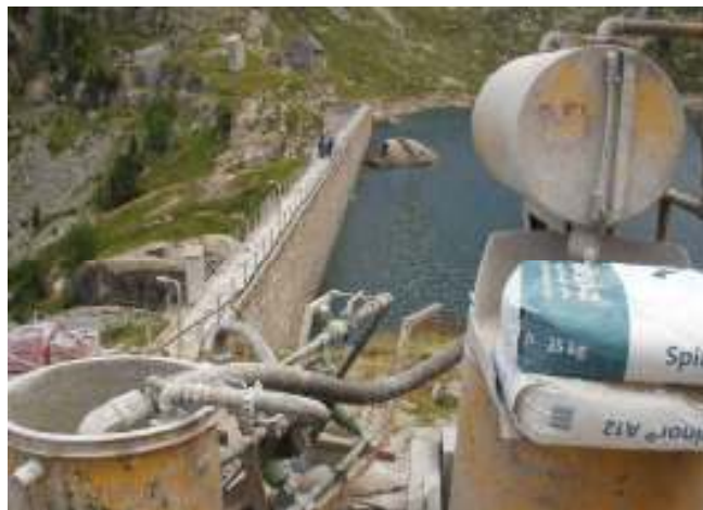
Vista del paramento aguas arriba de la presa.
