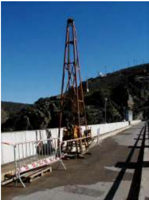
Vista de los equipos de perforación e inyección empleados durante las obras.
