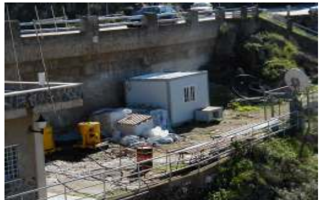
Vista del equipo de preparación de la lechada de inyección durante las obras.
