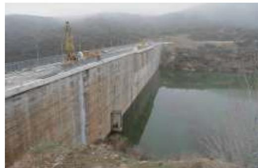
Vista del trasdós de la presa durante los trabajos de inyección.
