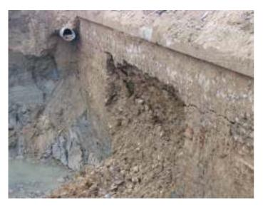
Derrumbes ocurridos en la fase previa a la inyección de microcemento Spinor A12 para consolidar las mamposterias.
