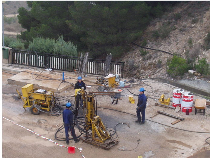
Foto 3.- Perforación de sondeos a destroza en el exterior (estribo derecho).
