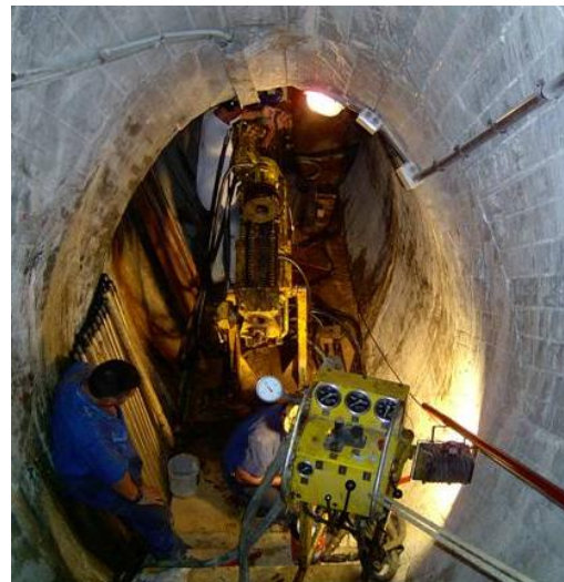
Foto 2.- Trabajos en interior de galería perimetral.
