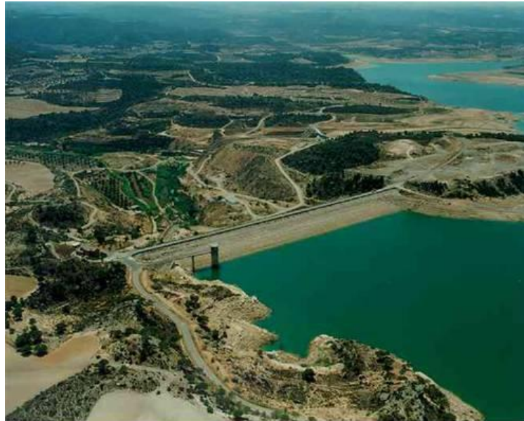
Foto 1.- Vista de la presa de Caspe.
