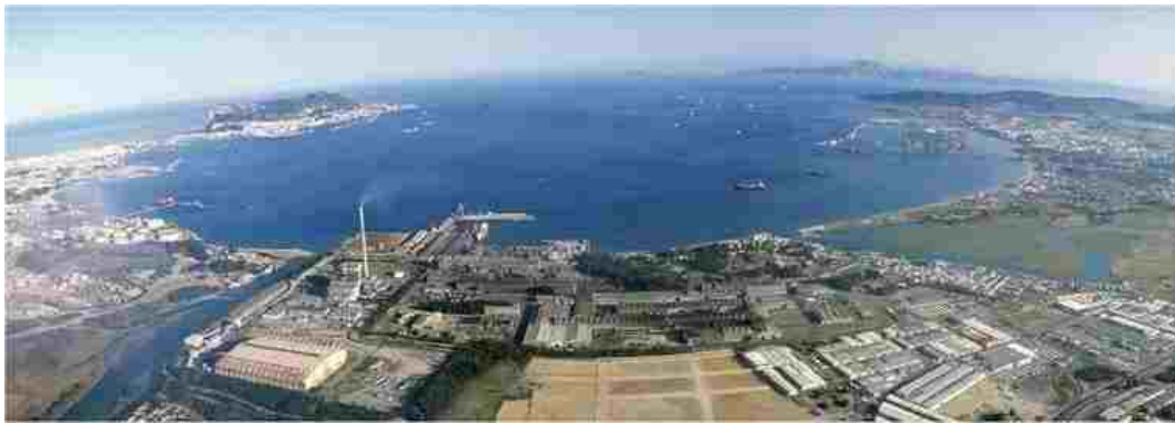
[Figura 1] Vista general de la factoría.
