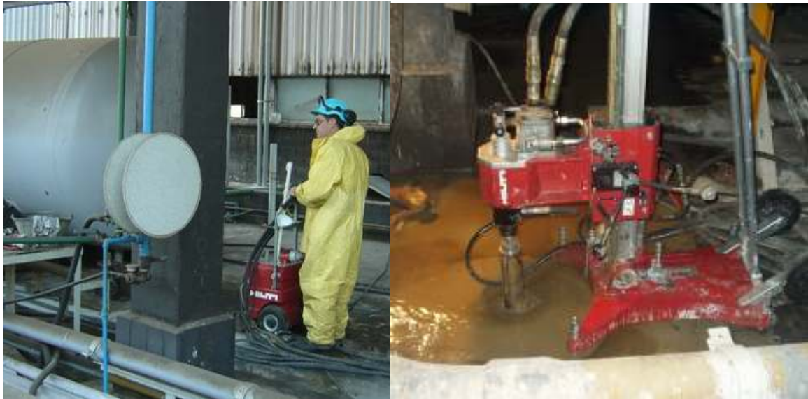
[Figura 3] Trabajos de perforación en zona de tanques e interior de nave respectivamente con equipos ligeros HILTI.
