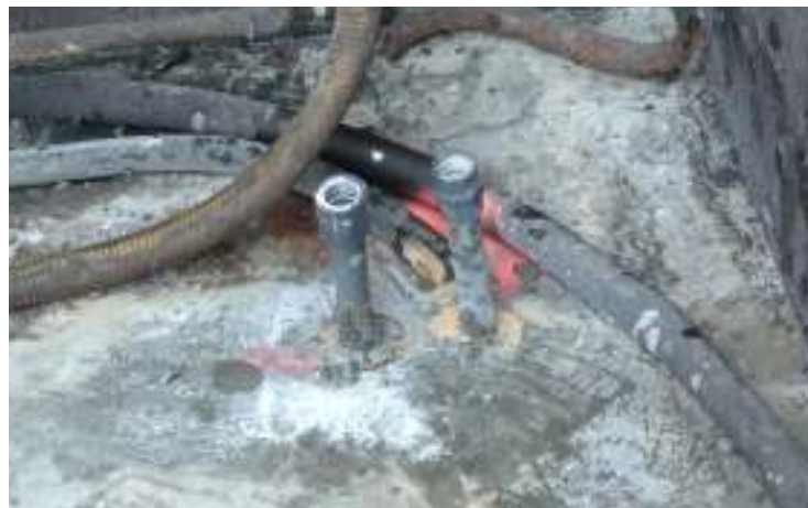
[Figura 4] Tubos manguitos de PVC de 3/4" de diámetro listos para inyectar.
