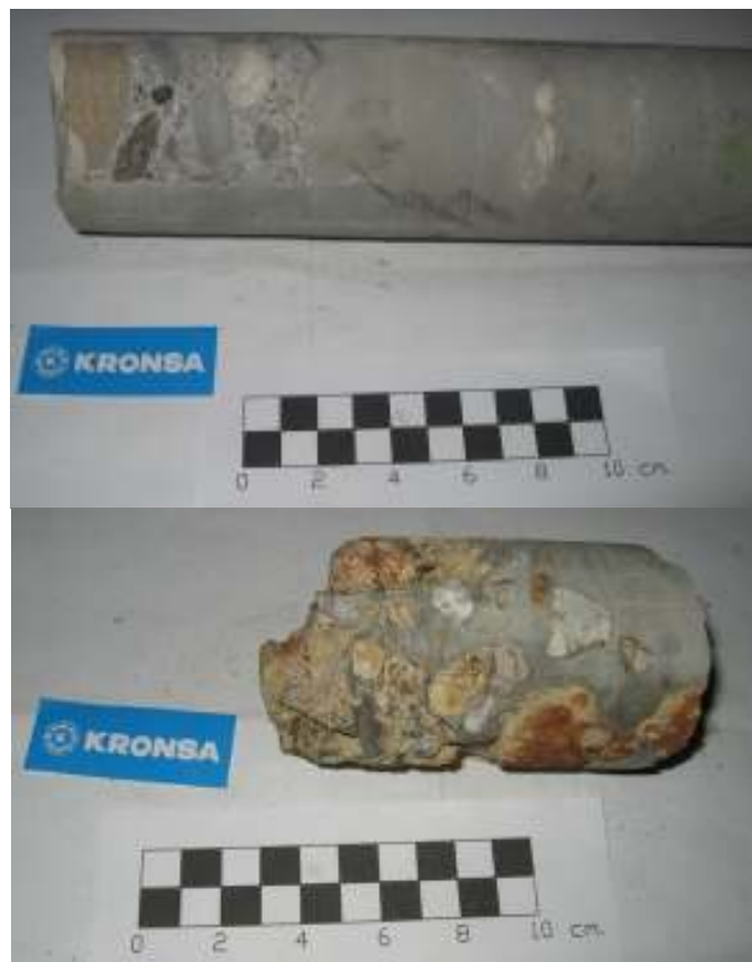
[Figura 8] Testigos mostrando la regeneración de la fábrica de hormigón de algunas de las estructuras de cimentación tratadas.
