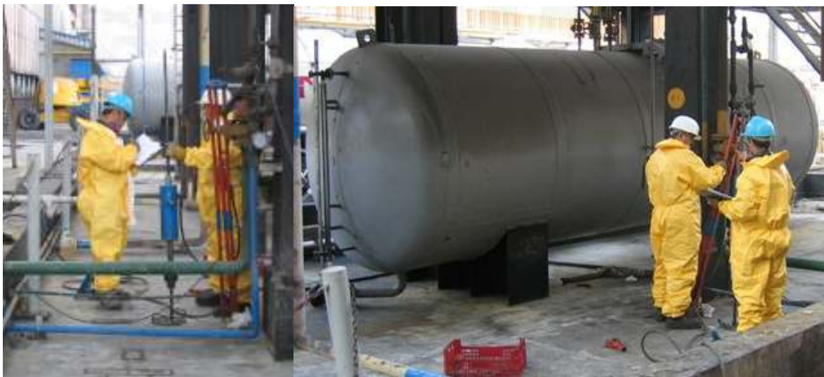
[Figura 6] Realización de ensayos ligeros de penetración tipo Stump en la zona de tanques de almacenamiento de ácidos.
